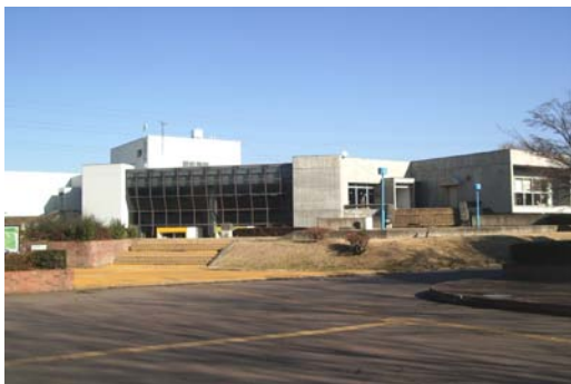
平砂学生宿舎共用棟
