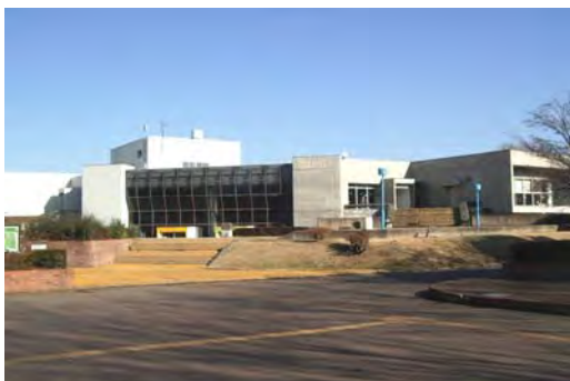
平砂学生宿舎共用棟
