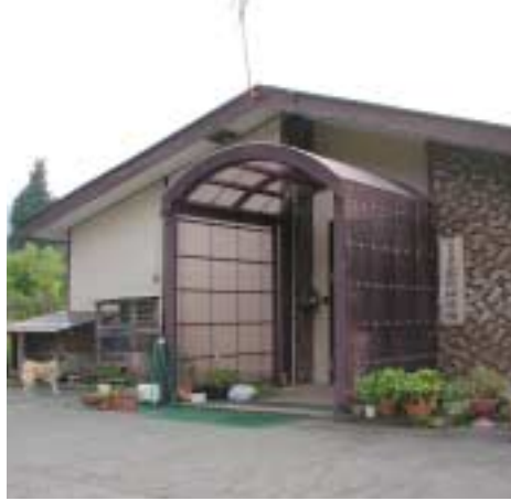
人 建物に被害はなかった石打研修所
