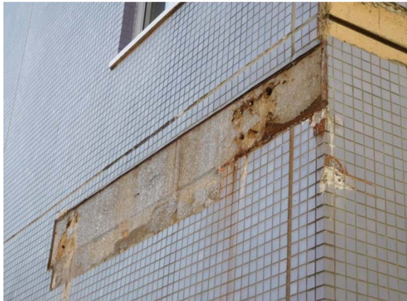
1C棟 固定箇所
