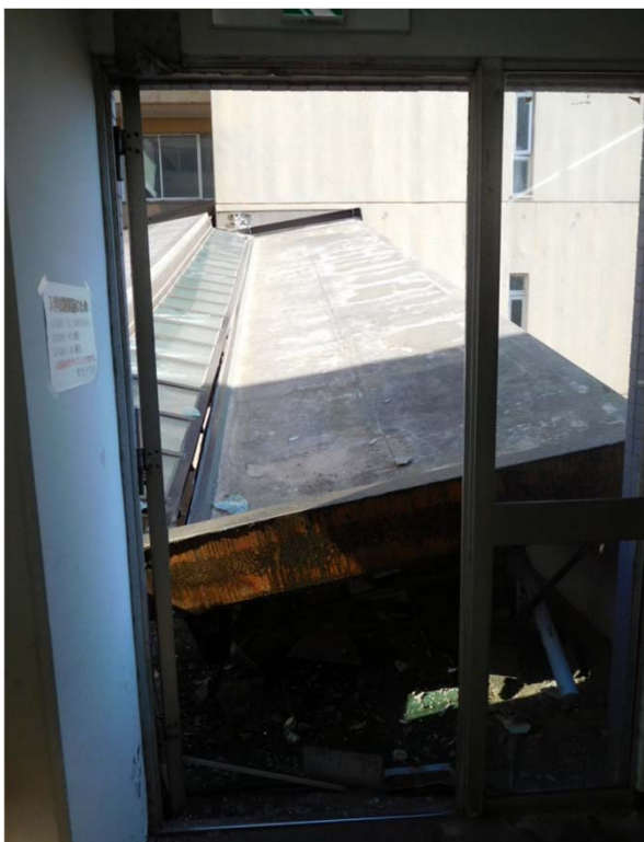
1C棟 出入口部分
