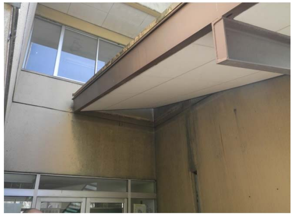
1B棟側 屋根の端部
