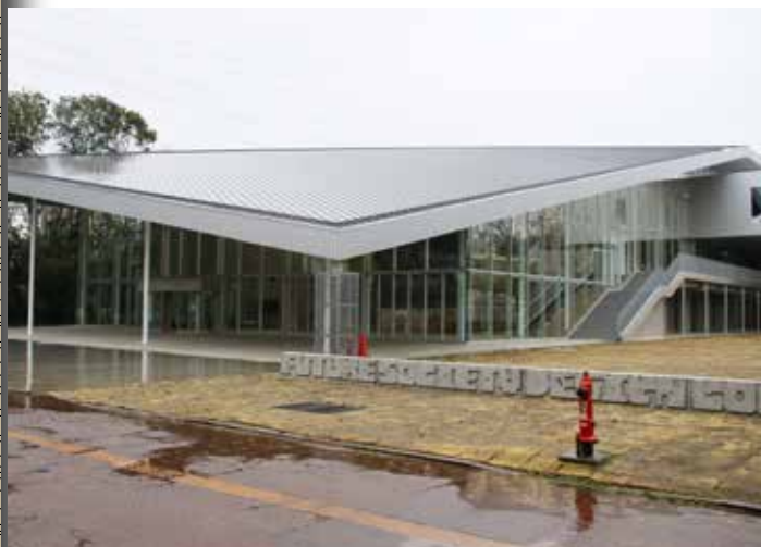
ガラス張りの外観が目立つ未来社会デザイン棟(3月26日、平砂宿舎で) =川畑悠成撮影
