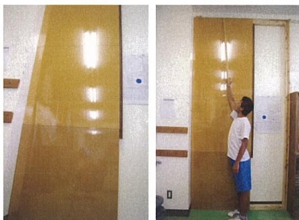
理科室の後ろの壁に6cm角材を固定し、2cm厚のベニヤ版を取り付ける。その表面に5mm厚のアクリル板を木工ねじで固定する。
