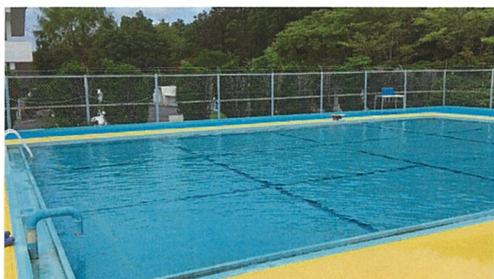
小学校のプール
