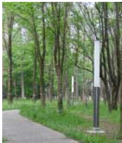
新たに設置された街灯(平砂・追越地区で)
