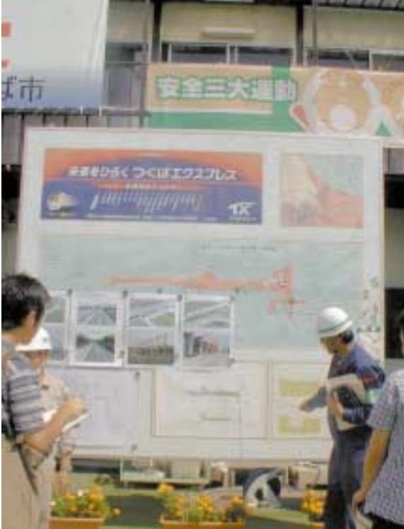
つくばエクスプレスの建設現場。作業員は安全な作業環境を整え、工事を進めている。
