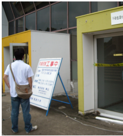
アスベスト工事中の平砂共用棟
