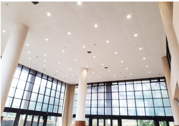
【南地区】筑波大学大学会館A棟等天井耐震改修工事
